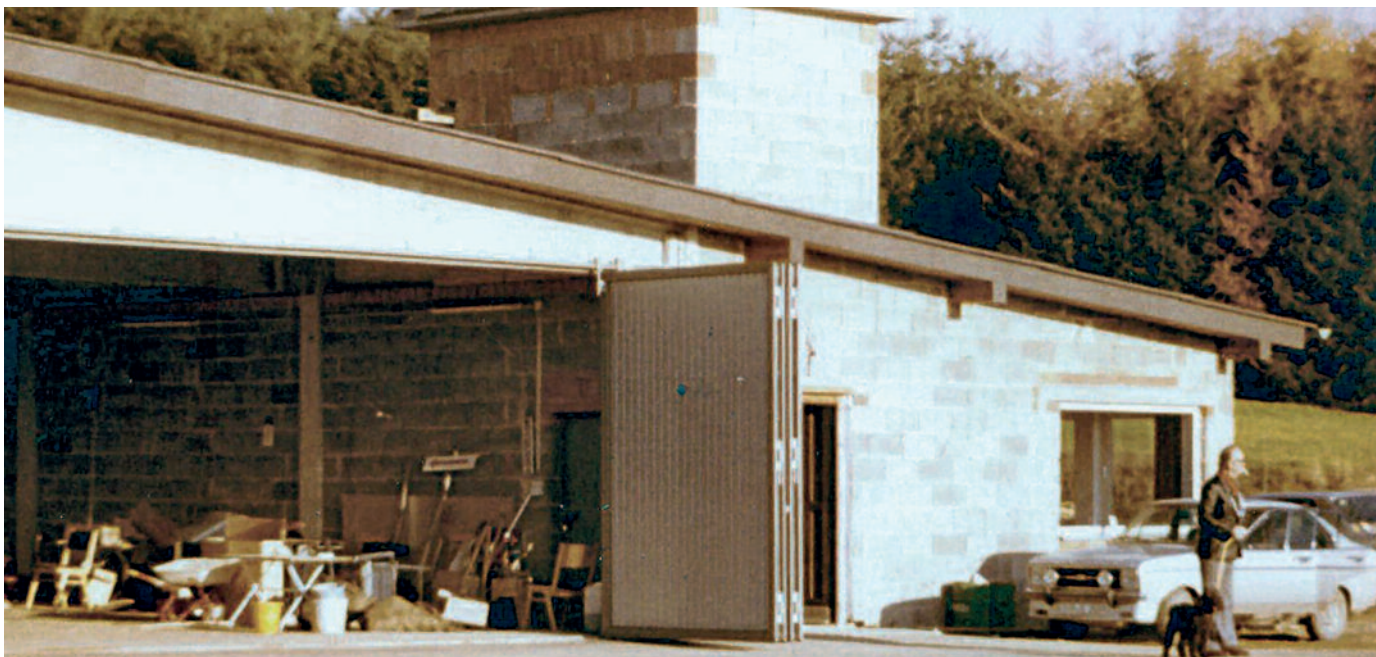
Blick auf die neue Halle, hier noch ohne Flugleitungsturm.
