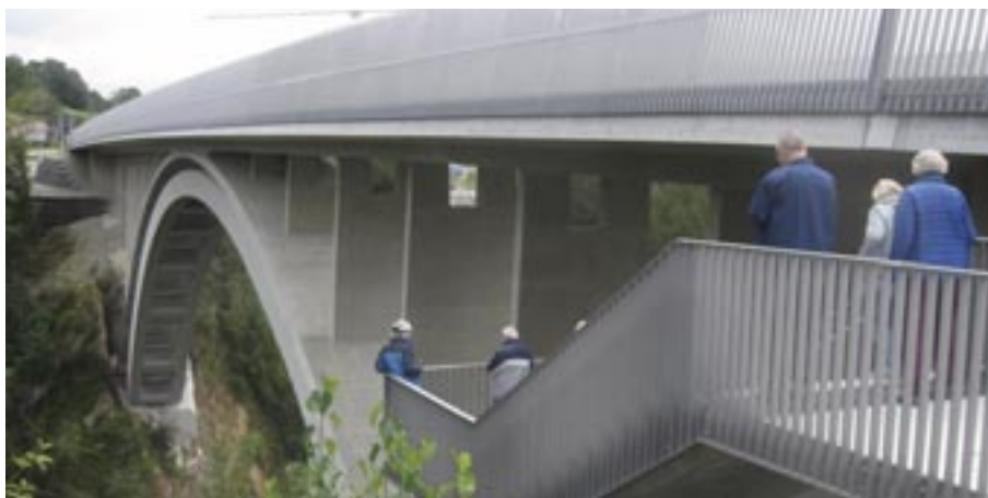
Bei der Echelsbacher Brücke, dem zweiten Stopp der Ausflugstour, werden die alten Brückenbögen durch neue Stahlbetonbögen gestützt und so erhalten.
