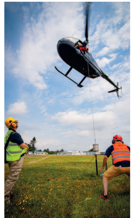
Mit dem präzisen Einlöchen des Kegels in die 30 cm große Dachluke brachte Copilot Wolff sein Team auf die Erfolgsspur.
