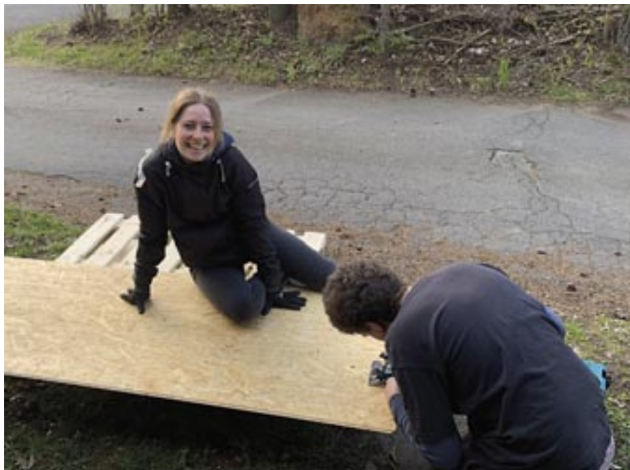
Einige der Vorbereitungsarbeiten an neuen Bausteilen des Trailers fanden im Freien statt.
