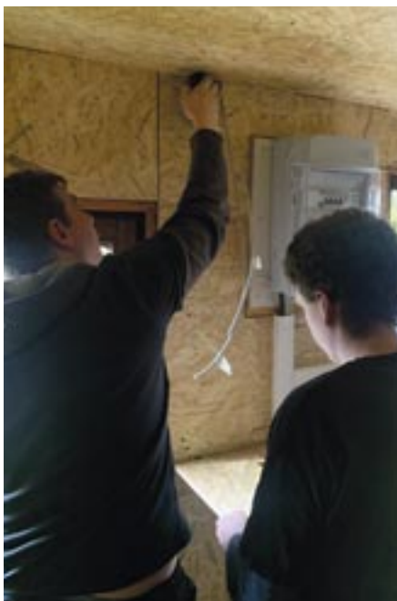
Auch der Innenausbau und die Erneuerung der Elektrik waren gut geplant.
