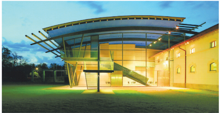
Blick von außen auf das Neue Foyer des Veranstaltungsforums.
